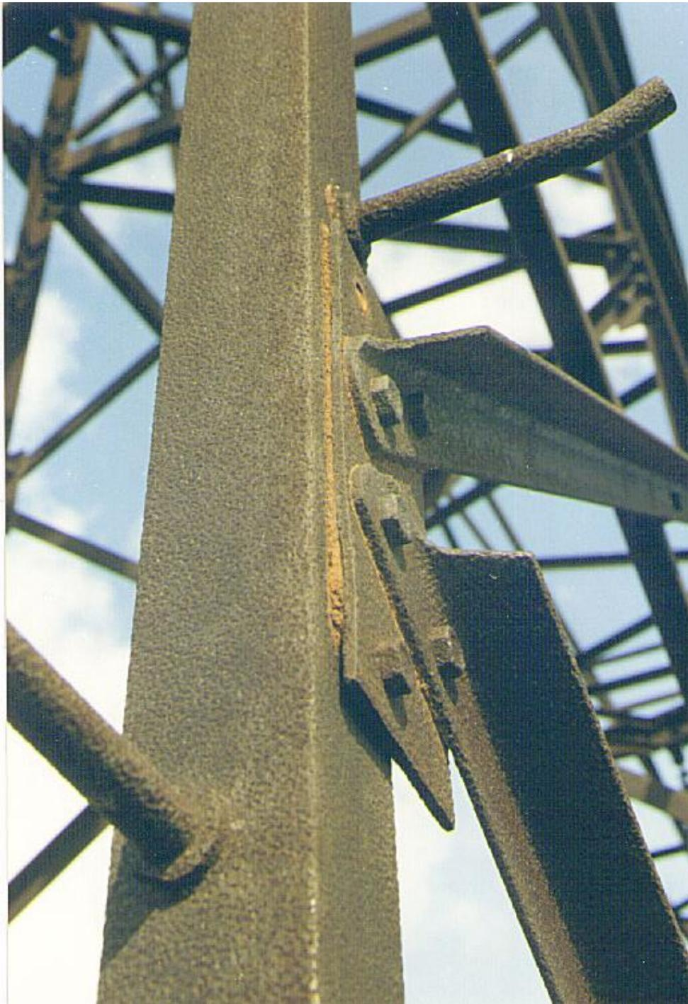
Foto N° 1. Corrosión de una estructura con acero Corten
